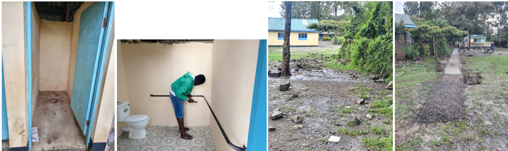
Voor en na foto's van het toilet en het pad (april 2024)
