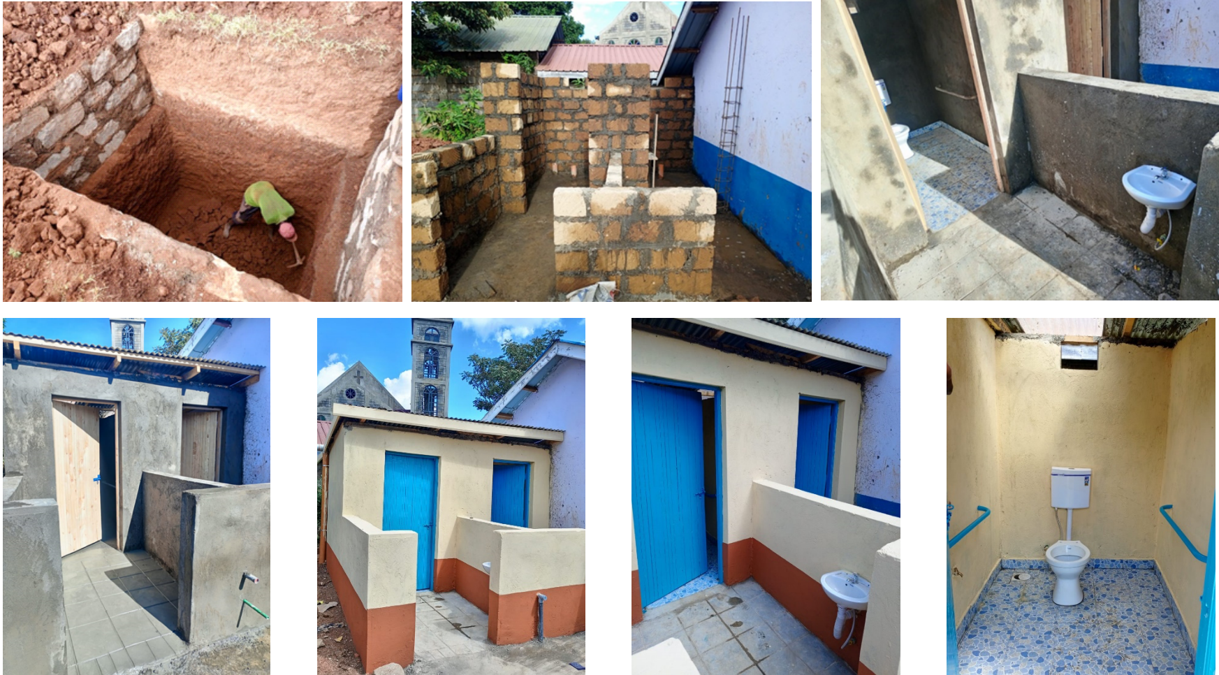
Het bouwen van het sanitair blok in Kamangu Primary School (november – december 2024)
